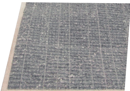
celle delaminate dal vetro delaminate glass cells
